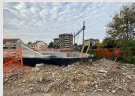
Area del cantiere nei pressi dei binari
