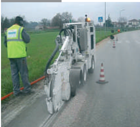
Lavori per la posa dei cavi in fibra ottica
