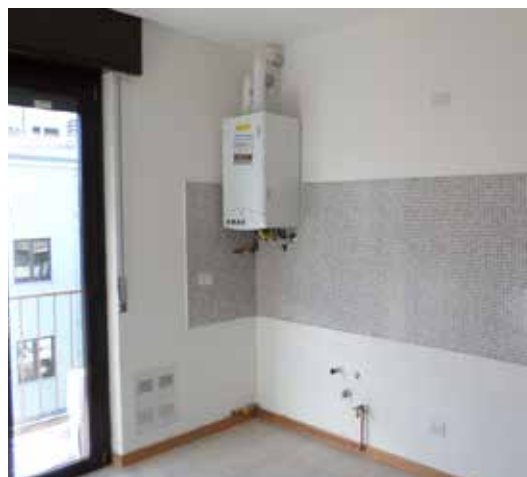
Da sinistra, l'impianto fotovoltaico di via Mazzucotelli e un esempio di manutenzione straordinaria alloggi sfitti
