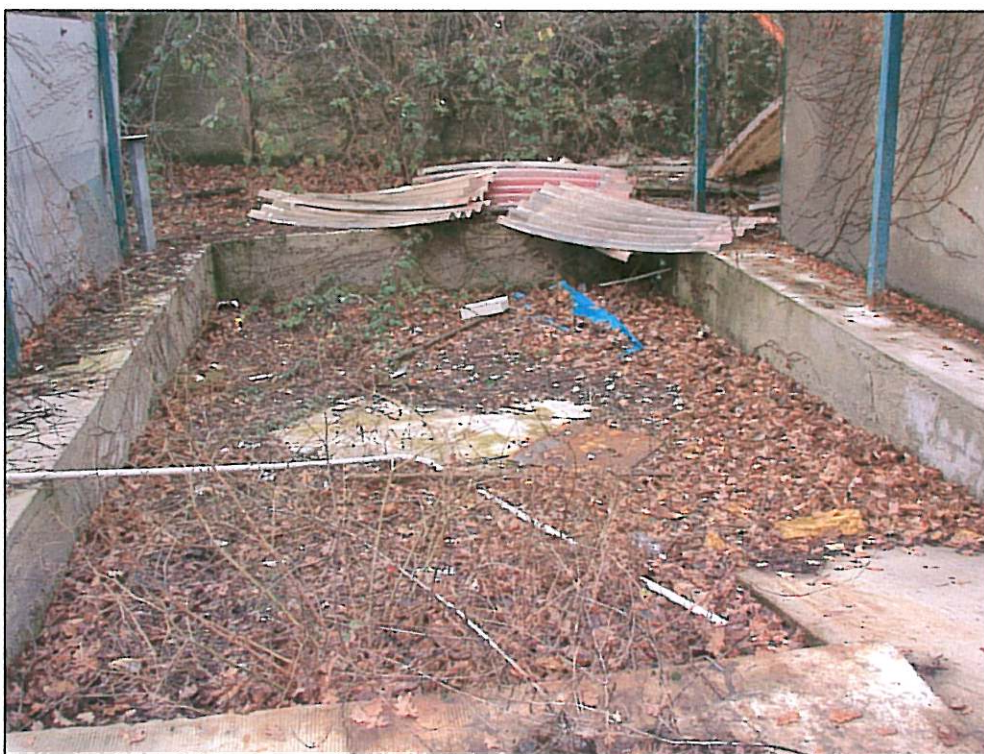
Foto 9 - Zona 3 (deposito vernici esterno): assaggio S6
