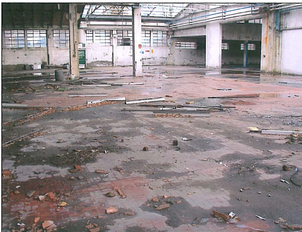
Foto 8 - Zona 3 (reparto verniciatura): assaggi S4 e S5
