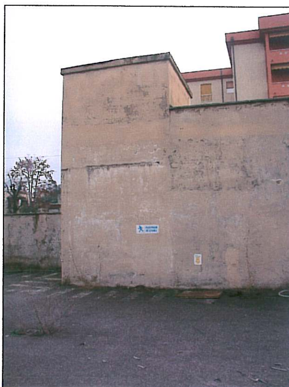
Foto 11 - Zona 5 (cabina elettrica): assaggio S8
