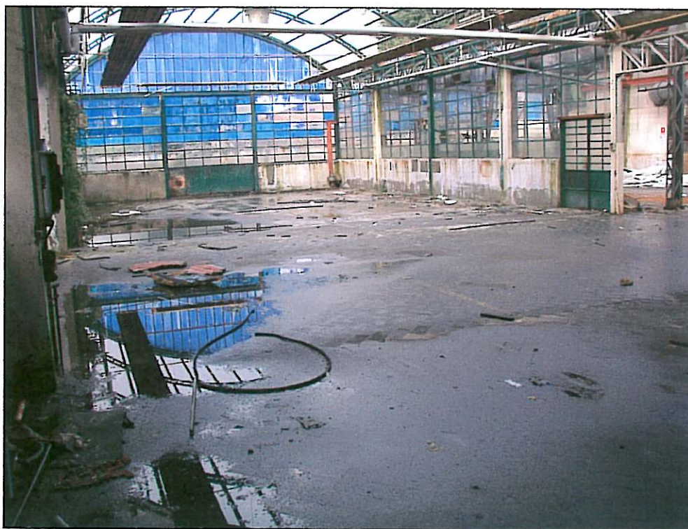
Foto 7 - Zona 2 (reparto saldatura): assaggio S3
