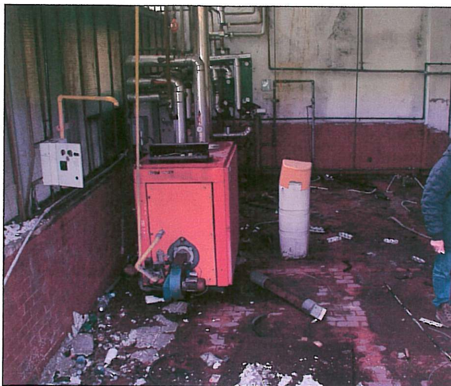
Foto 10 - Zona 4 (locale caldaia): assaggio S7
