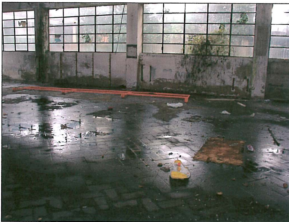
Foto 6 - Zona 1 (reparto tornitura): assaggio S1
