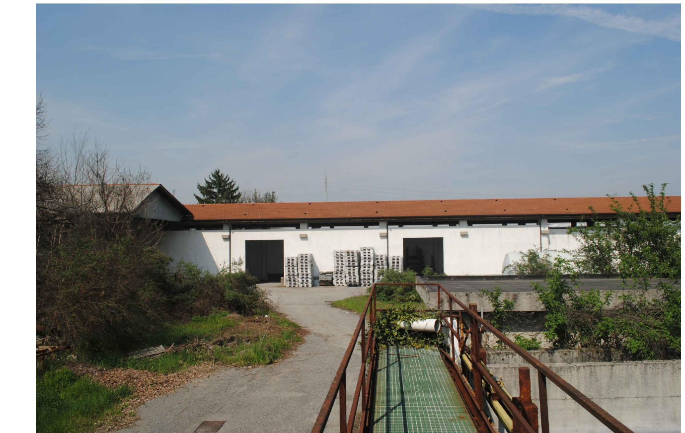
Foto 12 prospetto sud edificio O
