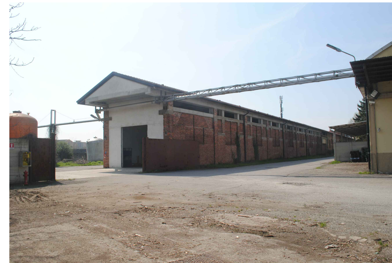
Foto 10 prospetto nord edificio O
