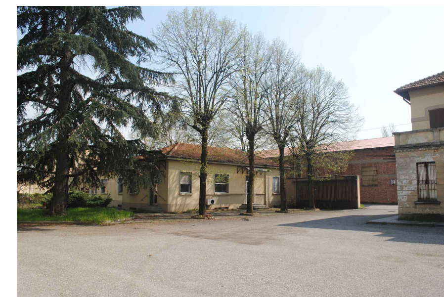
Foto 05 prospetto nord-ovest edificio M
