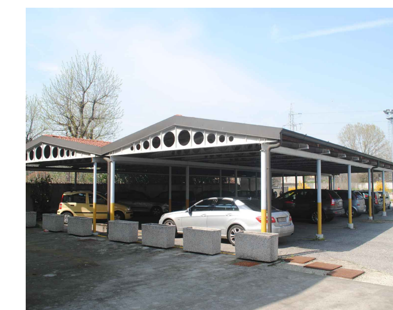
Foto 07 esterno edificio T
