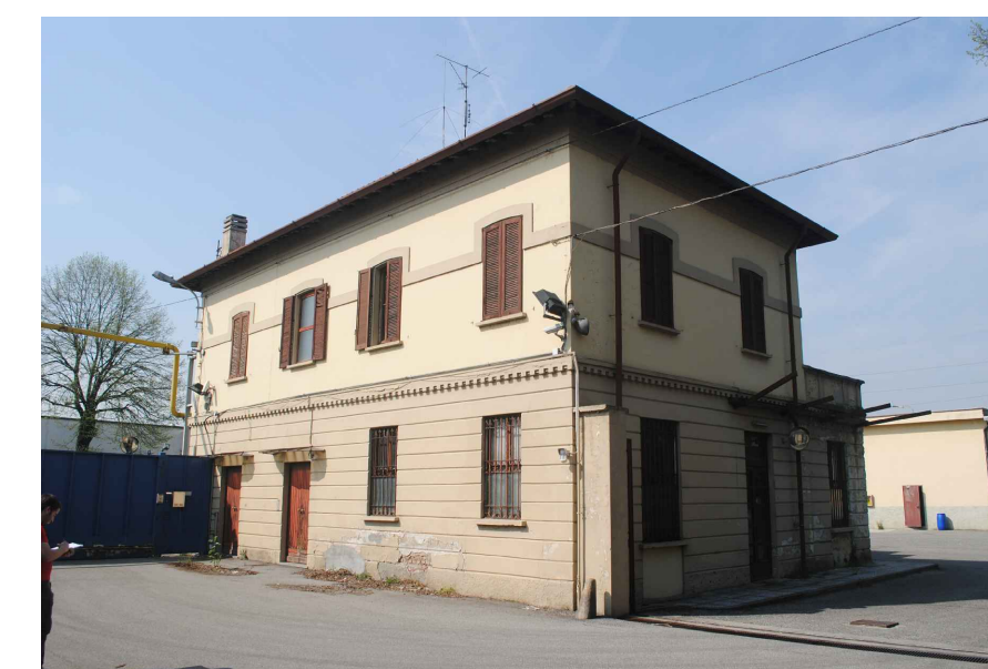
Foto 02 prospetto nord-ovest edificio L
