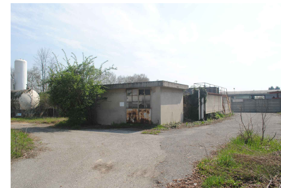
Foto 03 prospetto nord-est edificio P
