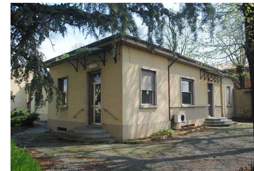
Foto 04 prospetto nord-ovest edificio M
