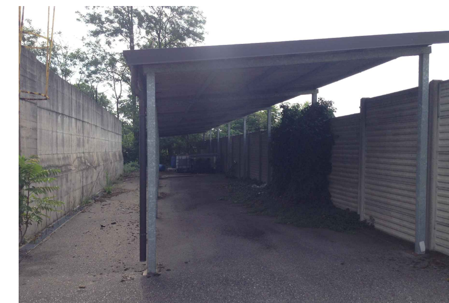
Foto 06 esterno edificio Q
