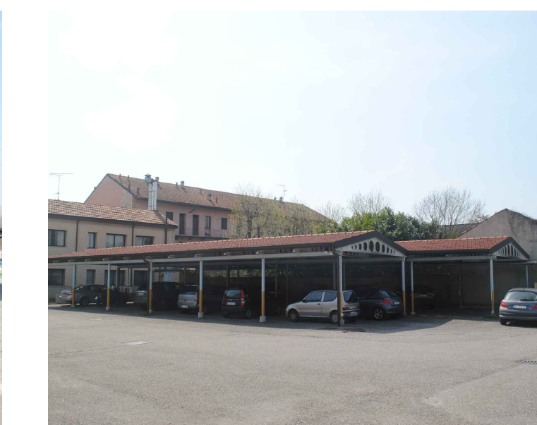
Foto 08 esterno edificio T
