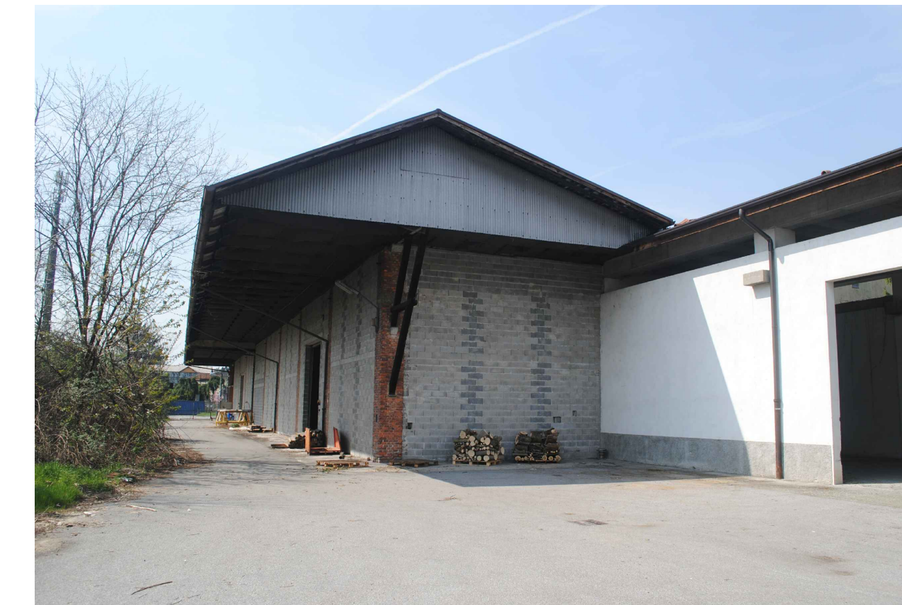
Foto 11 esterno edificio O
