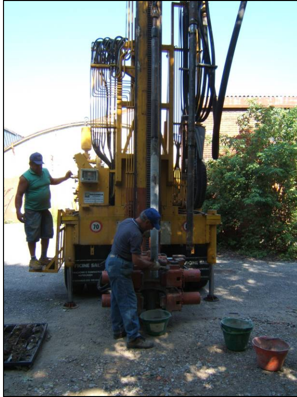
Fig. 11 - sonda di perforazione utilizzata
