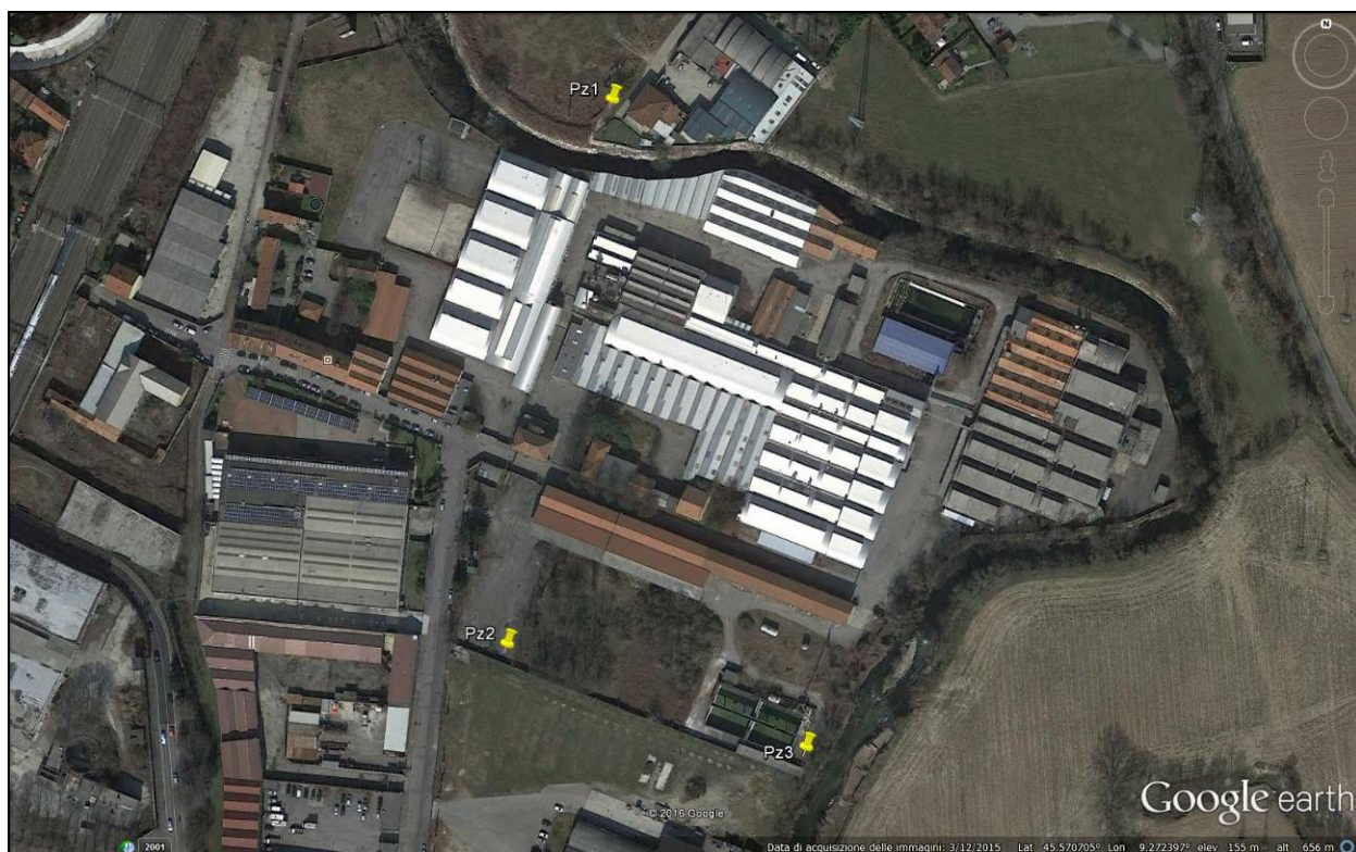
Fig. 9 - Estratto ripreso da Google Earth con l'ubicazione dei piezometri realizzati in fase di indagine preliminare.
