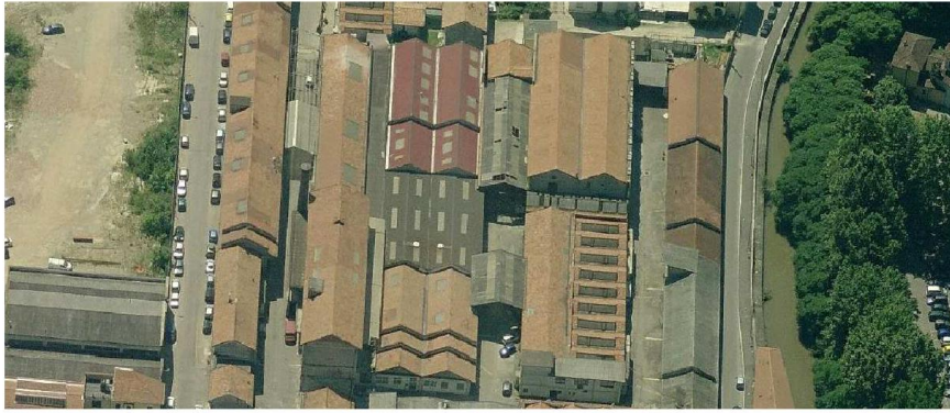
VISTA AEREA DA NORD
