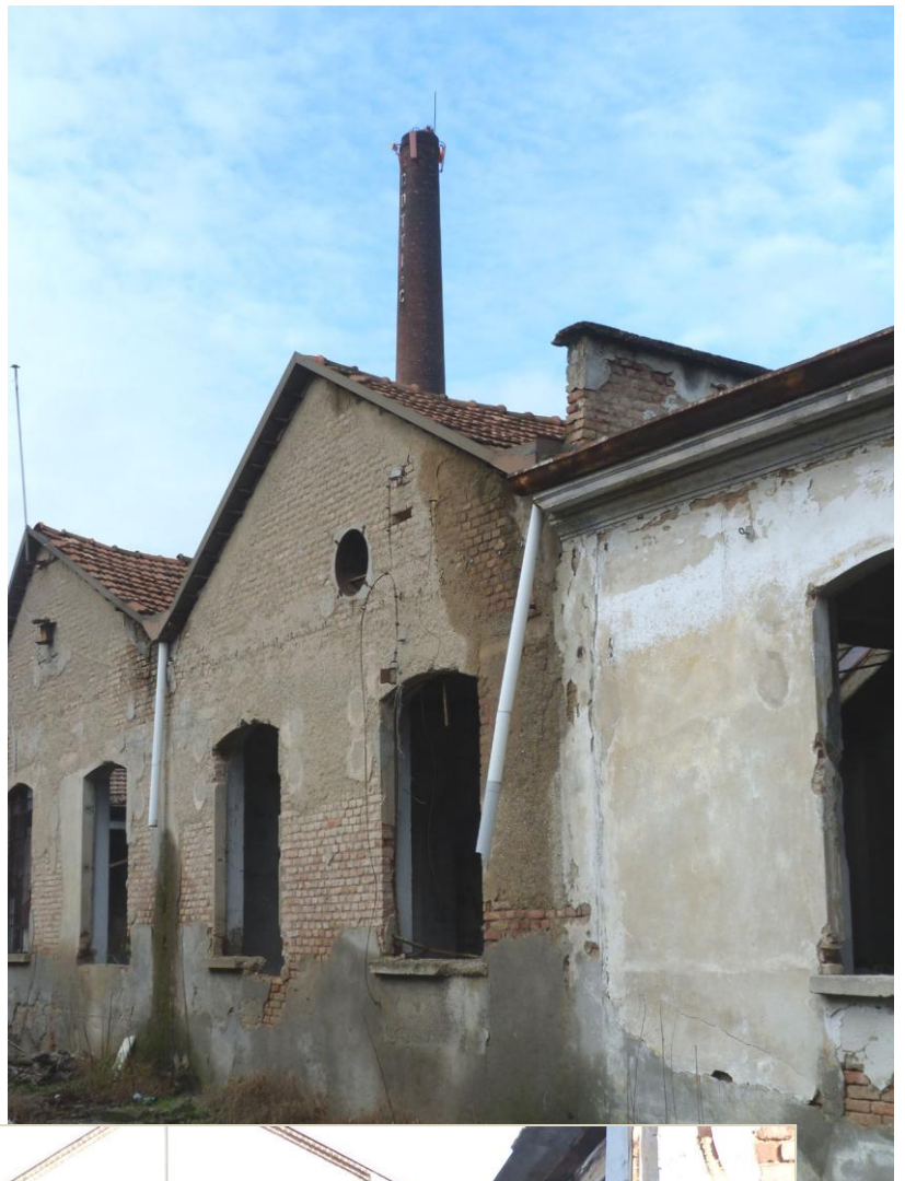
Foto 14 e 15: gli edifici dell'area acidaggio (lato) e, sullo sfondo, quelli adiacenti ("batterie" e "motore diesel")
