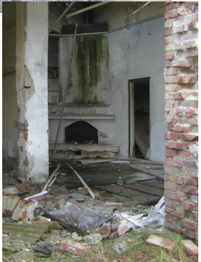
Foto 13: l'area magazzino colori e "chimico" come si presenta attualmente
