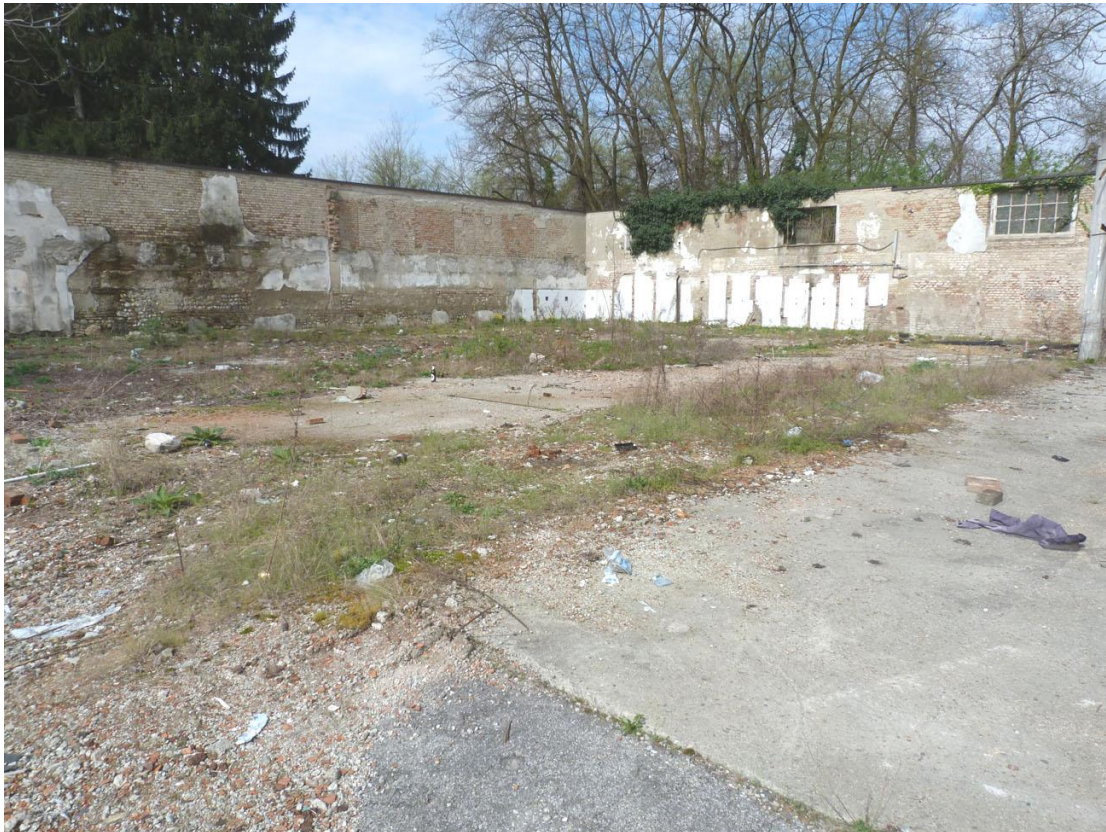
Foto 10: porzione di nord ovest dell'area, dove erano un tempo ubicate le officine meccaniche ex Scotti
