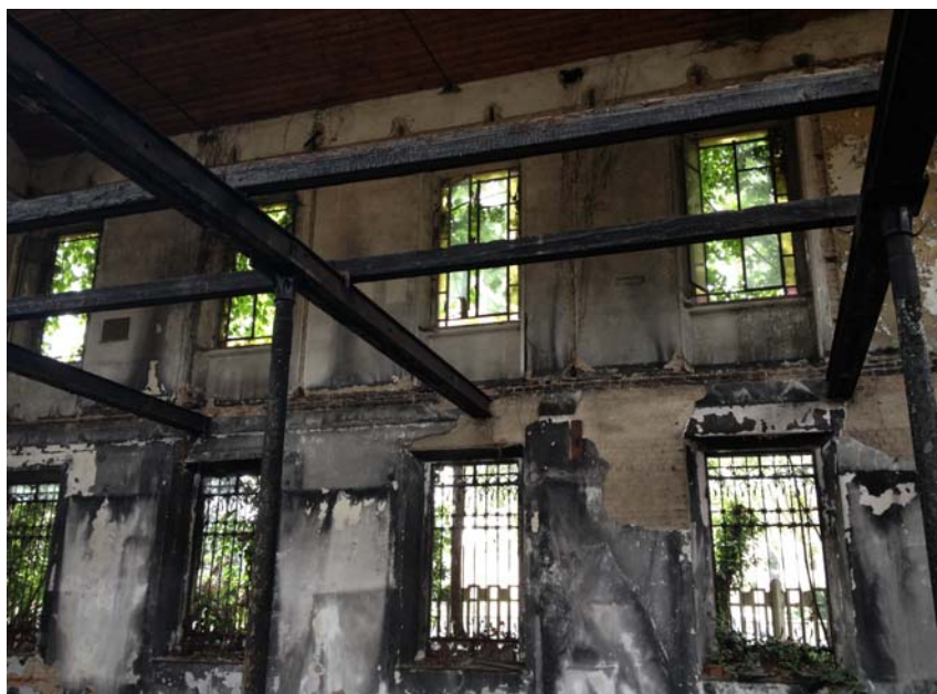
Foto 4- ex casa delle Aste- vista interna.
