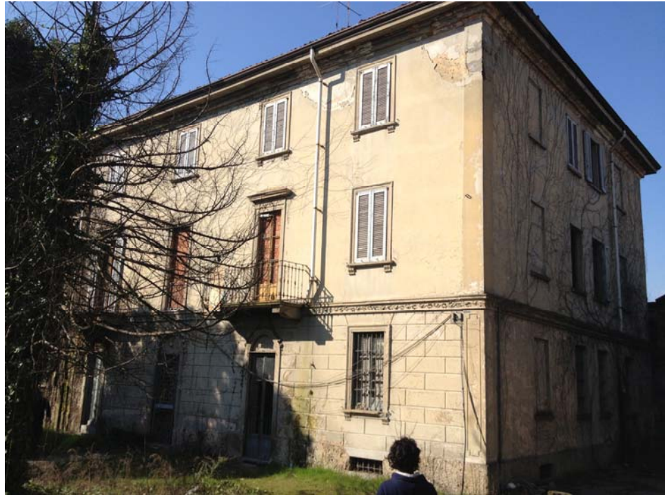
Foto 1-ex Villa Azzurra- facciata su viale Cesare Battisti.
