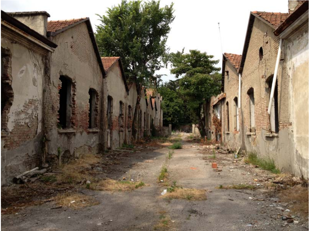
Foto 13- vista strada interna est/ovest.
