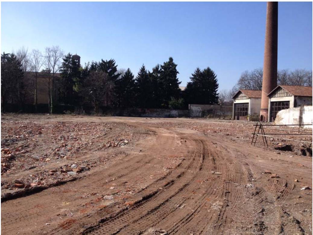
Foto 13-STATO ATTUALE- vista strada interna est/ovest a seguito delle demolizioni effettuate dal dicembre 2014 al febbraio 2015.
