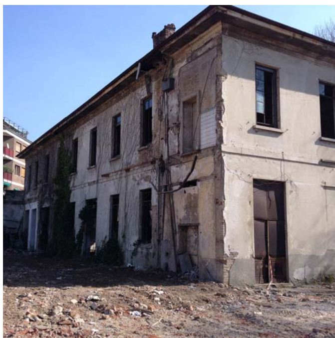
Foto 6a-STATO ATTUALE-ex Casa delle Aste- angolo nord-ovest a seguito della demolizione del volume superfetativo
