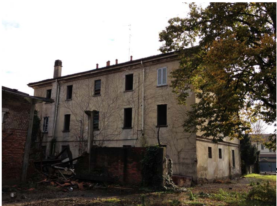
Foto 2-ex Villa Azzurra- facciate nord ed ovest
