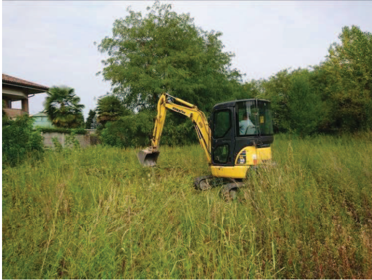
Fotografia 9 – Escavazione trincea T5
