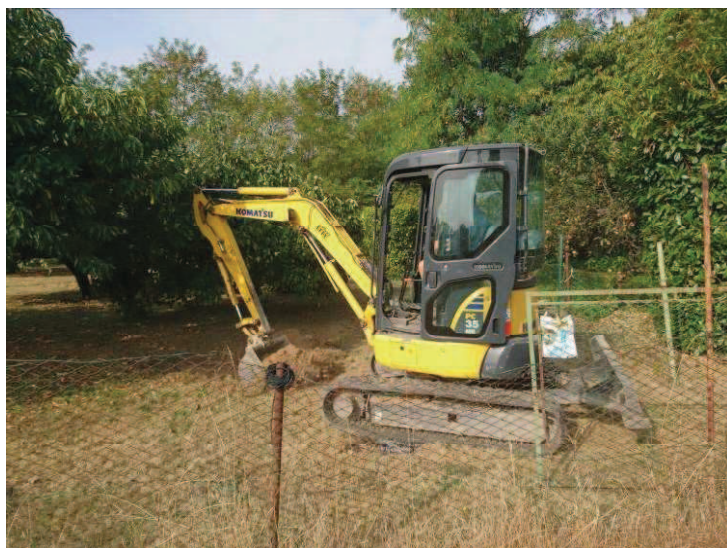
Fotografia 7 – Escavazione trincea T4
