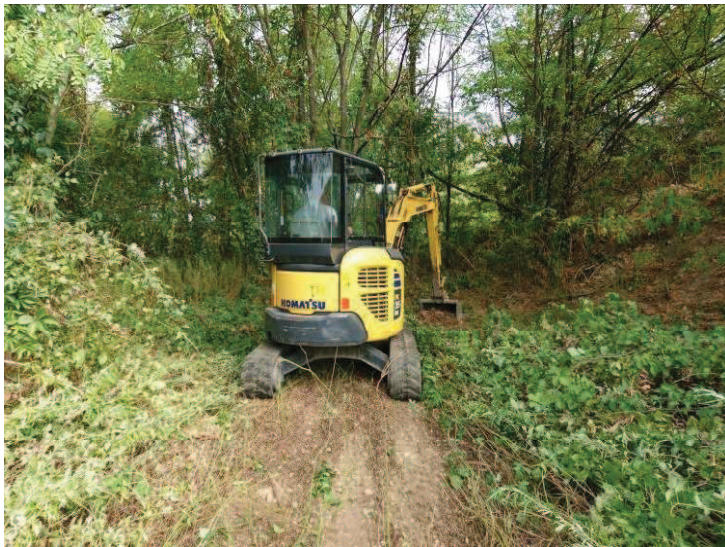
Fotografia 11 – Escavazione trincea T6
