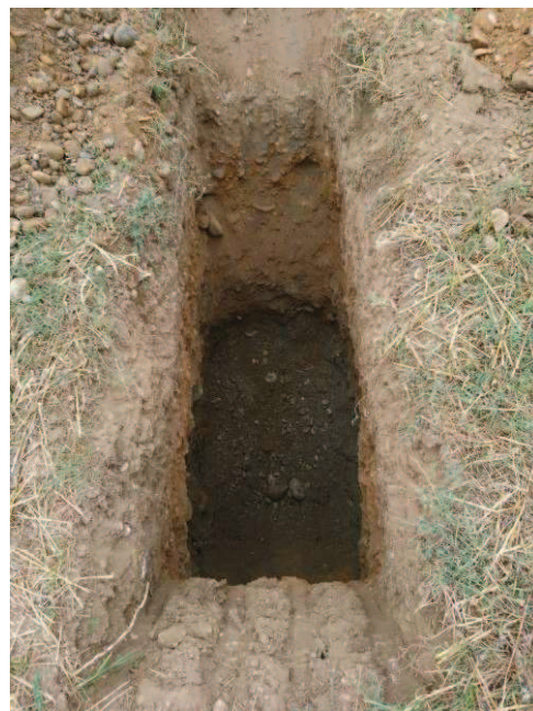
Fotografia 2 – Trincea T1 da 0.0 a 3.0 m
