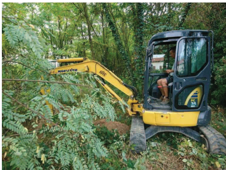
Fotografia 3 – Escavazione trincea T2
