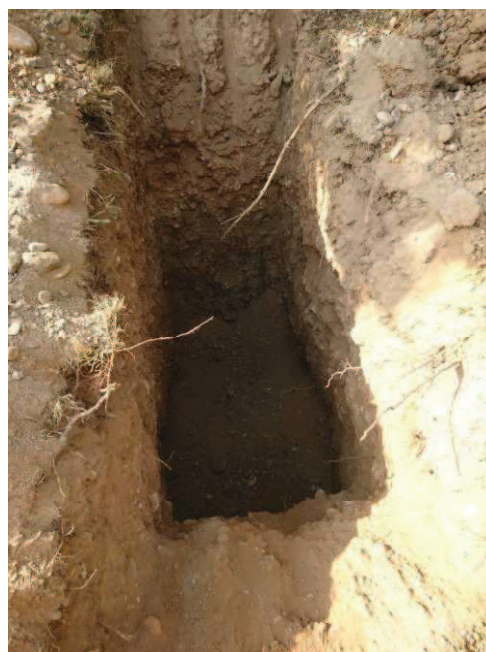
Fotografia 8 – Trincea T4 da 0.0 a 3.0 m
