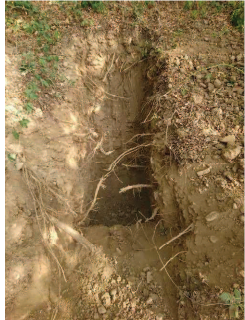
Fotografia 12 – Trincea T6 da 0.0 a 3.0 m
