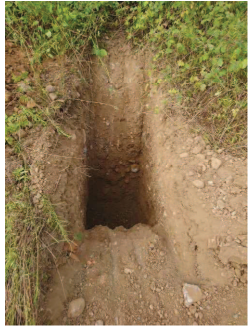
Fotografia 10 – Trincea T5 da 0.0 a 3.0 m
