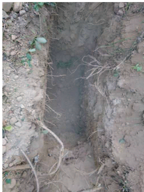
Fotografia 4 – Trincea T2 da 0.0 a 3.0 m
