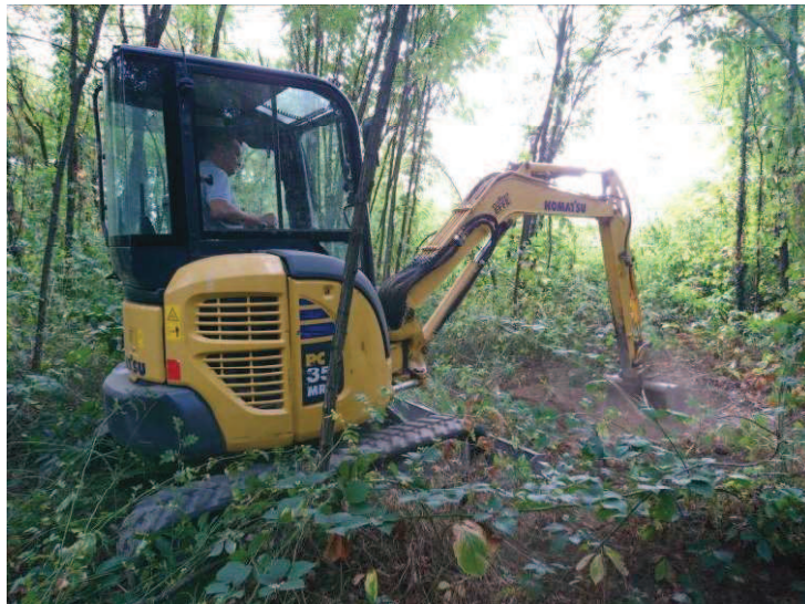
Fotografia 5 – Escavazione trincea T3
