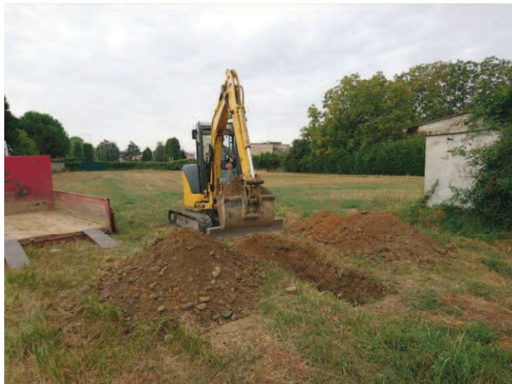
Fotografia 1 – Escavazione trincea T1
