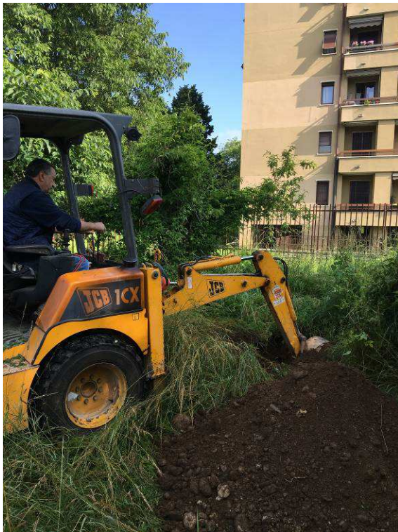
Esecuzione degli scavi nel mappale 263.
