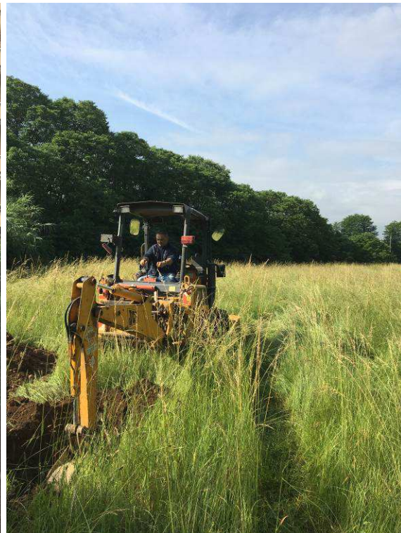
Esecuzione degli scavi nel mappale 266.
