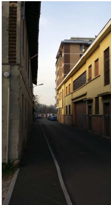
Punto di vista da via Confalonieri verso corpo di fabbrica esistente (mappale n°28) che verrà demolito. L'edificio residenziale sorgerà in arretramento rispetto al filo stradale (vedi planimetria – stato di progetto).
