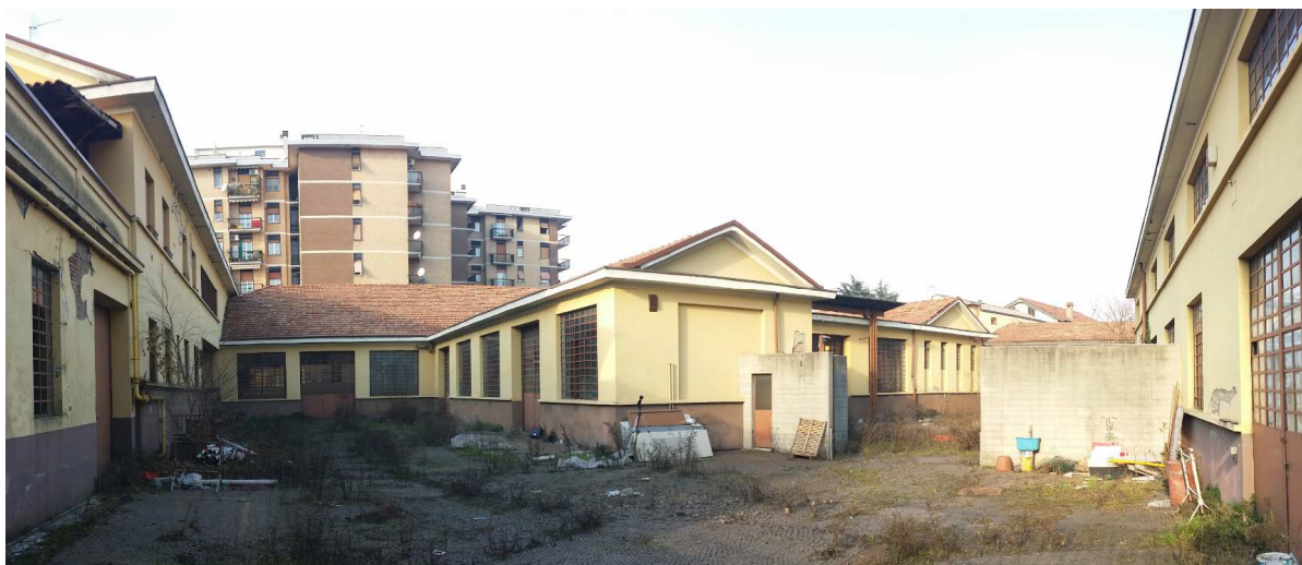
Punto di rilievo prescelto per l'indagine fonometrica interno al lotto oggetto di intervento
