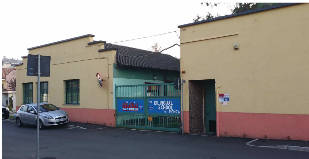
Il fabbricato sede dell'attività privata di scuola bilingue in fregio alla via Confalonieri sul lato opposto della strada a dove sorgerà il nuovo fabbricato ad una distanza di circa 70 m.
