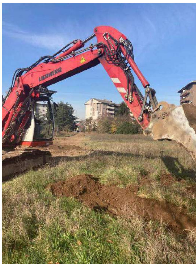
Esecuzione degli scavi.
