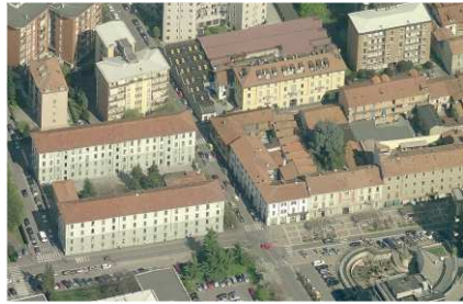
Edifici antichi e di valore testimoniale
