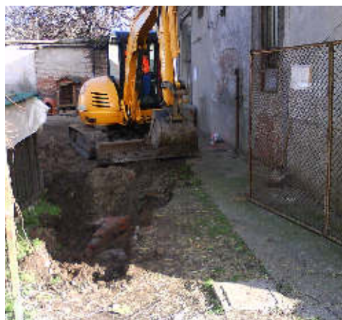
Scavo ed individuazione del serbatoio a circa 1,5 metri di profondità
