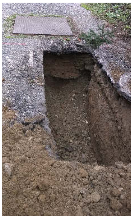
Scavo con individuazione del serbatoio cilindrico
