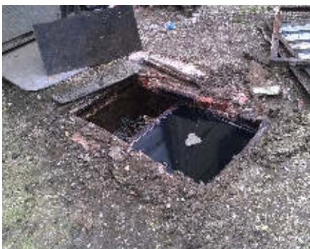
Serbatoio superficiale di forma cubica
