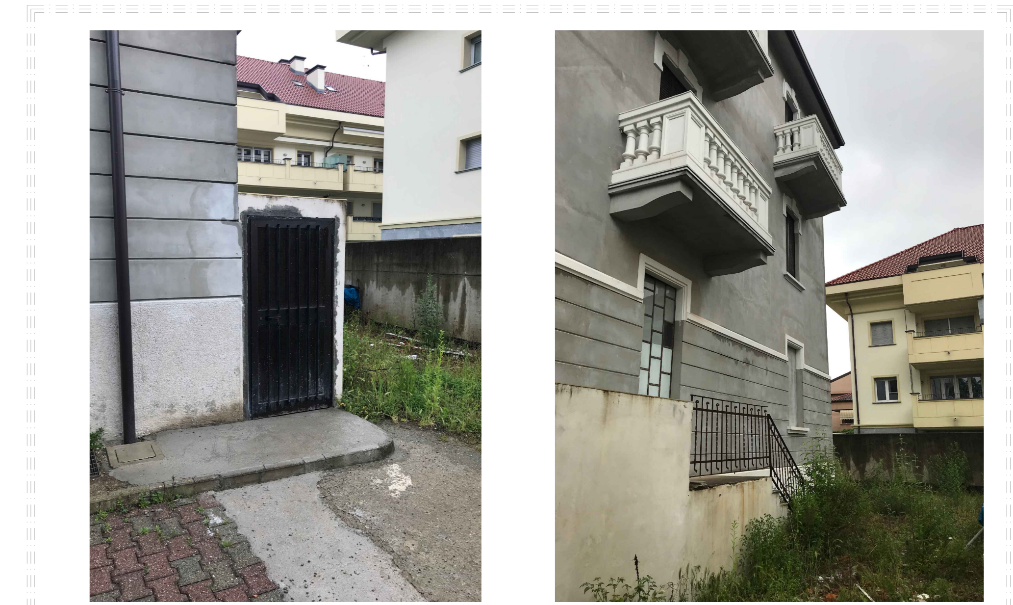
RILIEVO FOTOGRAFICO CONFORMAZIONE PIANEROTTOLO E SCALE TRA PIANO INTERRATO E PIANO RIALZATO LATO SUD
