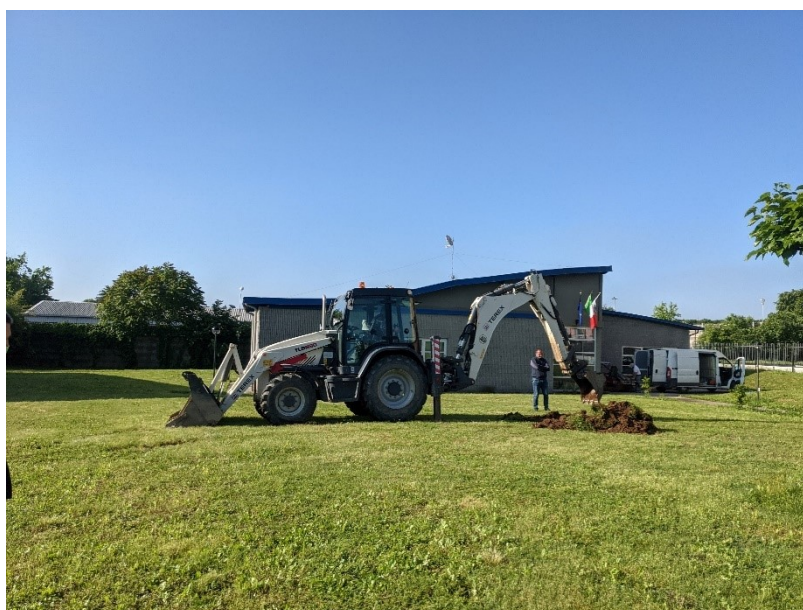
Esecuzione Trincea esplorativa TK1
