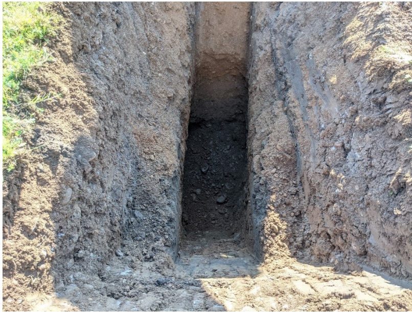
Trincea esplorativa TK1
