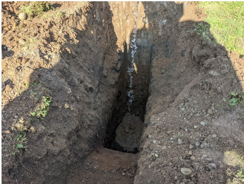
Esecuzione prova di permeabilità
