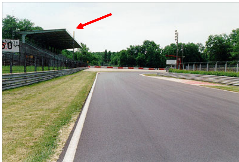
Tribuna della parabolica (struttura n. 9)
