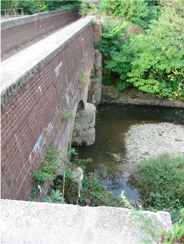
Figura 40 Passaggio del Canale Villoresi sul Lambro
