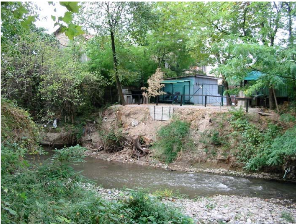
Figura 41 Occupazione di parte del corso del fiume mediante riporto in terra. Lambro poco a monte della confluenza con la roggia Lupa
