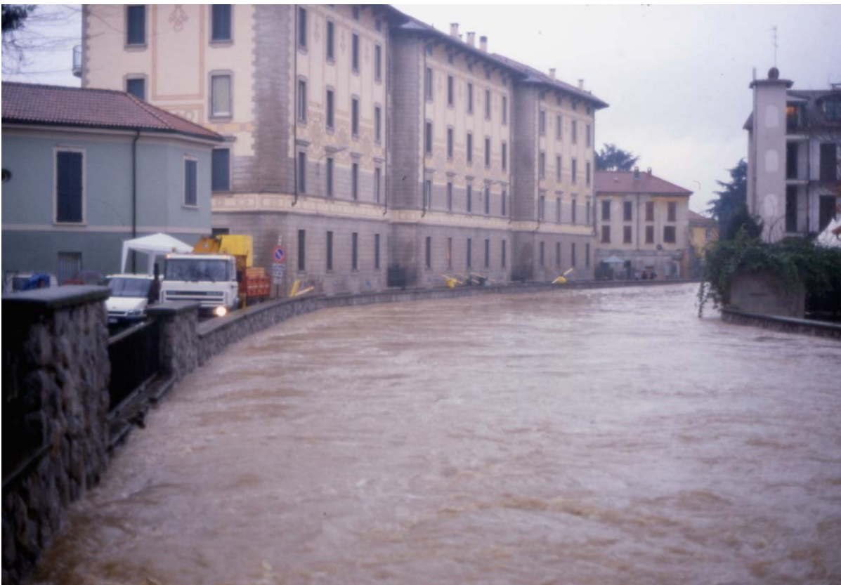
Figura 35 Durante l'alluvione 2002 (ore 16.00; vista da nord verso sud)
